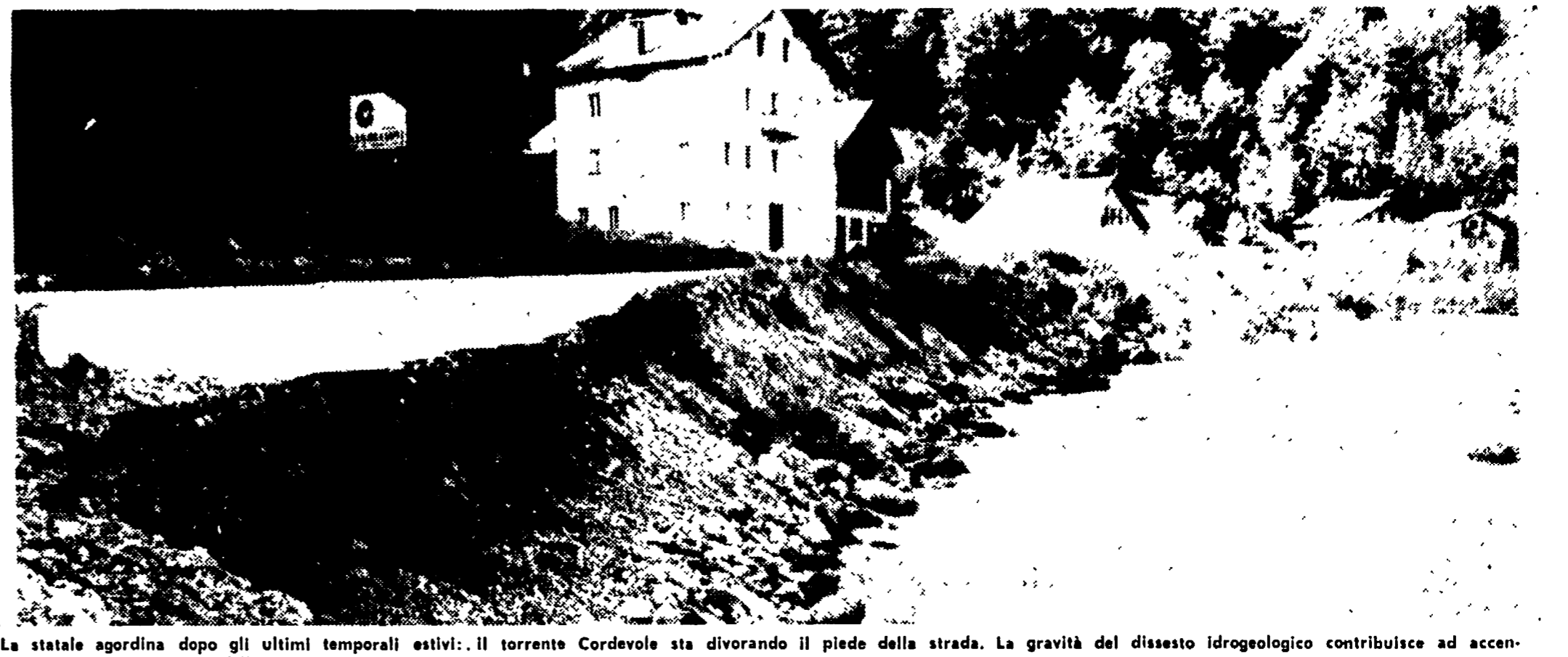
Lo stato agordino dopo gli ultimi temporali estivi: il torrente Cordevole sta divorando il piede della strada. La gravità del dissesto idrogeologico contribuisce ad accentuare la crisi economica della montagna.
