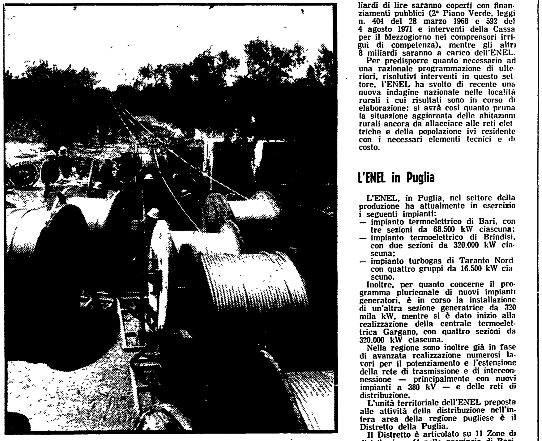
La messa in opera dell'elettrodotto 380 Kv Foggia-Taranto.
