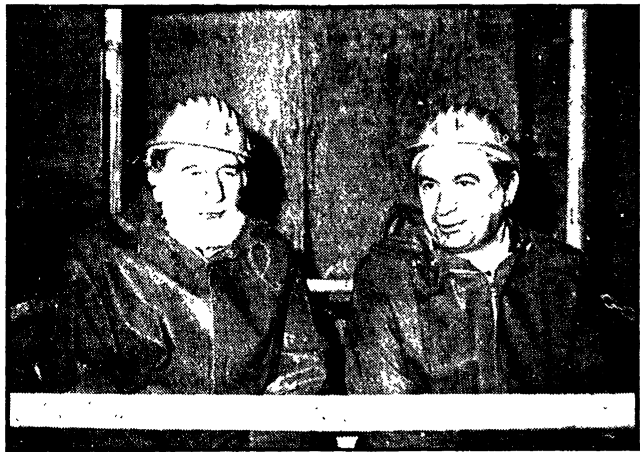
Derida e Bozzi nel tunnel della metropolitana
