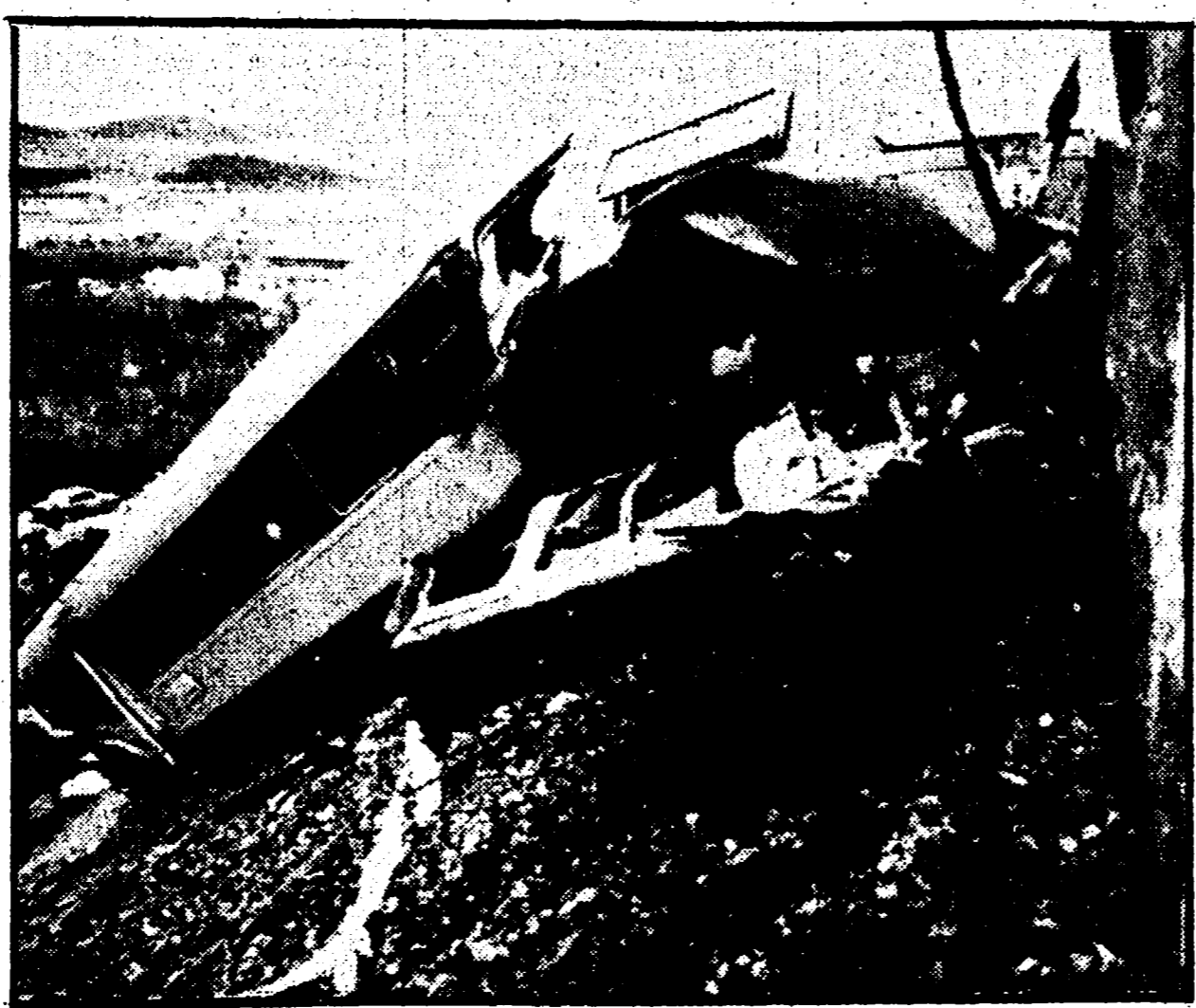
DERAGLIA IL RAPIDO: UN MORTO Alle 6,30 di ieri mattina, alla stazione di Bivio Aurlina (quindici chilometri da Trieste) il rapido Trieste-Milano è deragliato finendo nel terrapieno. L'incidente è avvenuto perché il vagono di un treno merci, che aveva sbagliato binario, ha ostruito la linea sulla quale stava per transitare il rapido. Il macchinista del convoglio passeggeri rimase ucciso. Nella foto: il luogo dell'incidente
