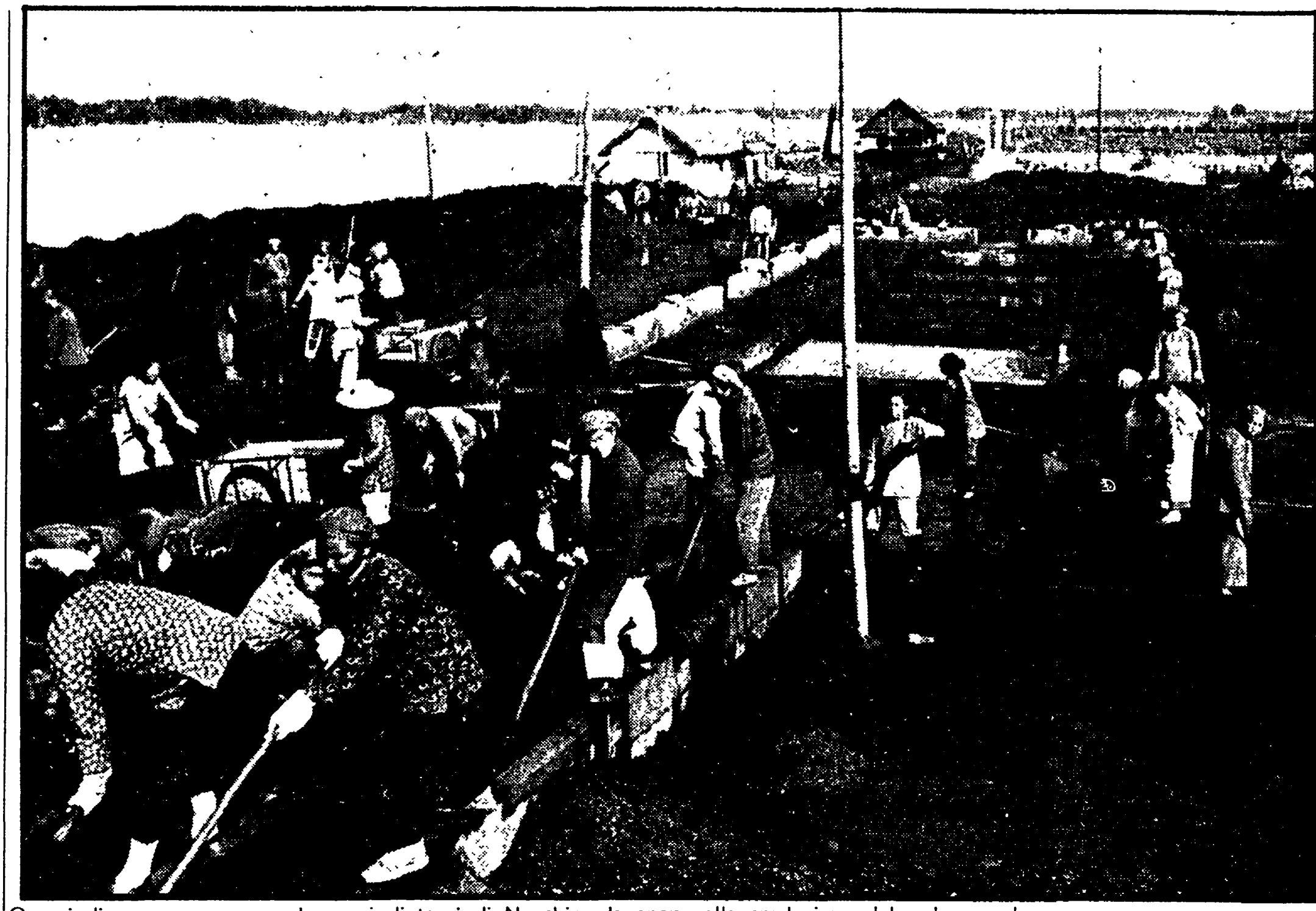
Operai di una comune popolare nei dintorni di Nanchino lavorano alla produzione del carbone coke
