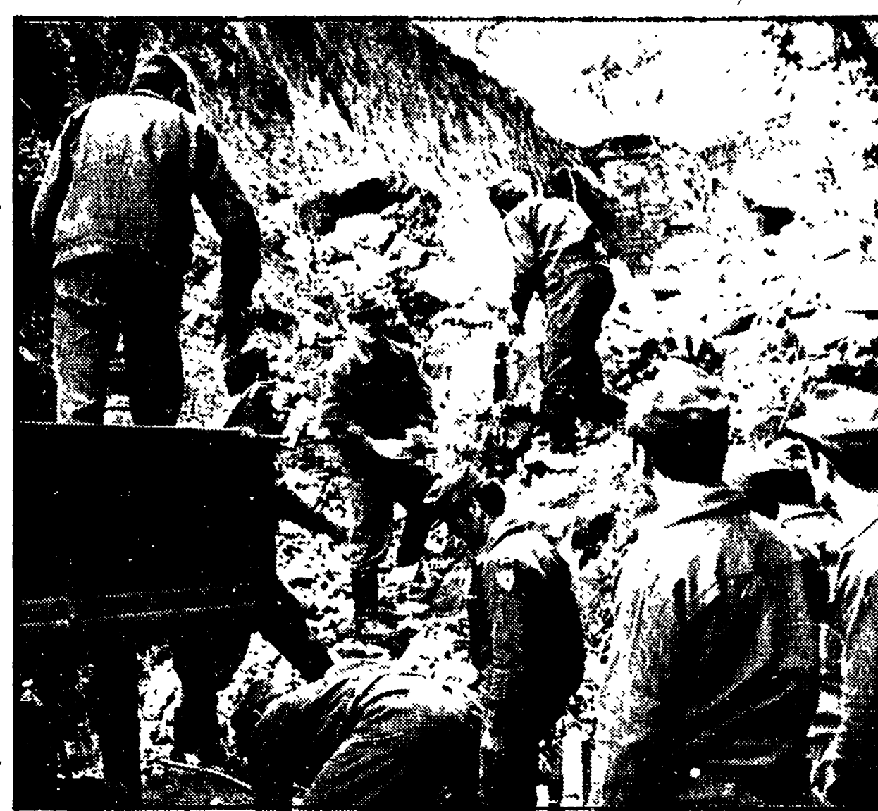
I vigili al lavoro per sgomberare la massa di detriti abbattuti sulla palazzina al Gianicolense; per qualche ora si è temuto che delle persone vi fossero rimaste sepolte
