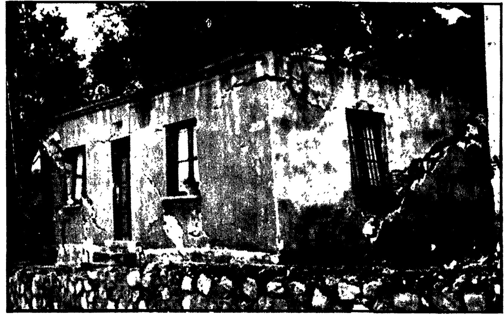
Una casa colonica di Careri (in provincia di Reggio Calabria) distrutta dal movimento franoso di ieri notte. La frana interessa oltre mille ettari di terreno
