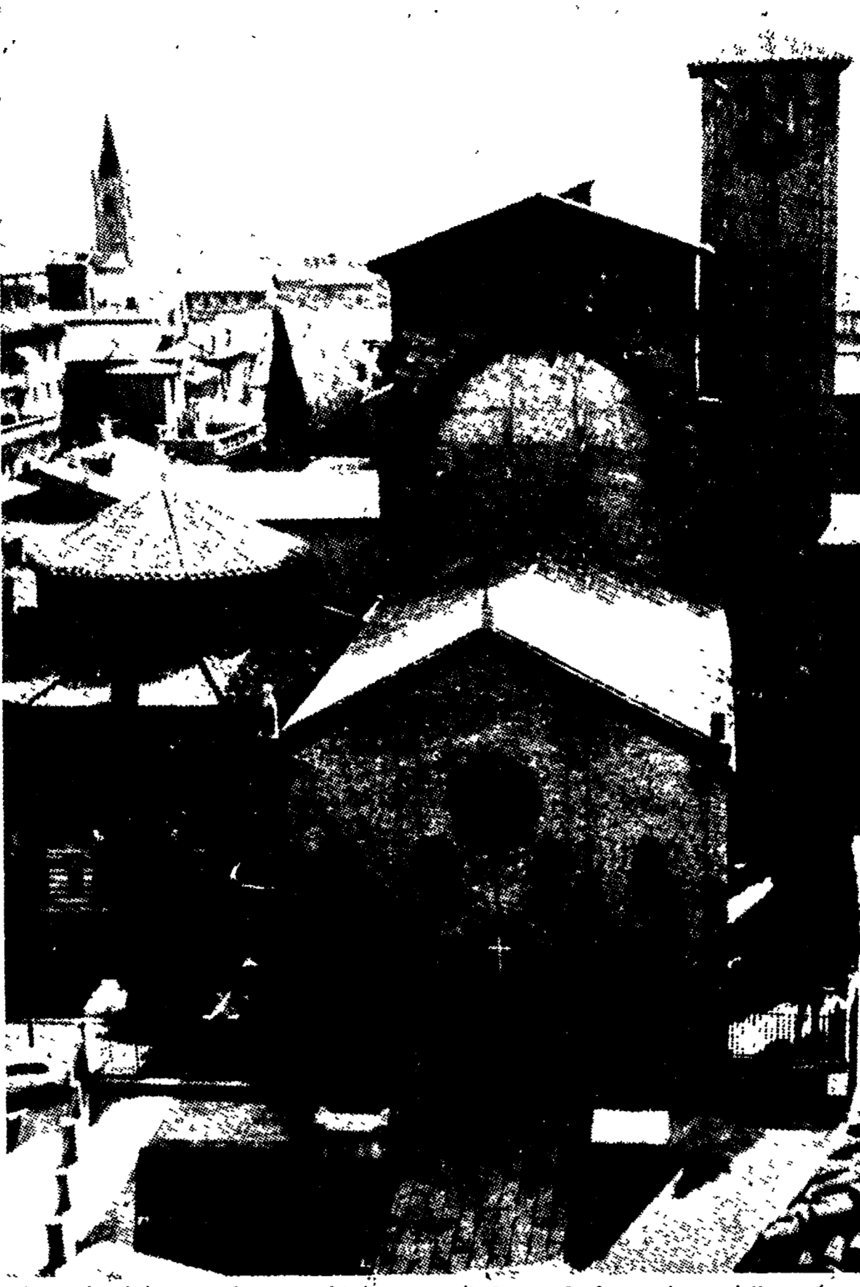
Lo splendido complesso architettonico di Santo Stefano, detto delle «sette chiese» poiché raccoglie altrettante costruzioni realizzate in diversi stili, non è più — contrariamente a quanto mostra la foto di repertorio — disturbato dal traffico. Infatti, proseguendo nell'opera di pedonalizzazione che investe in modo particolare il centro storico ma anche la periferia, l'amministrazione comunale ha recentemente chiuso al transito veicolare la piazza che fronteggia il prezioso monumento.
