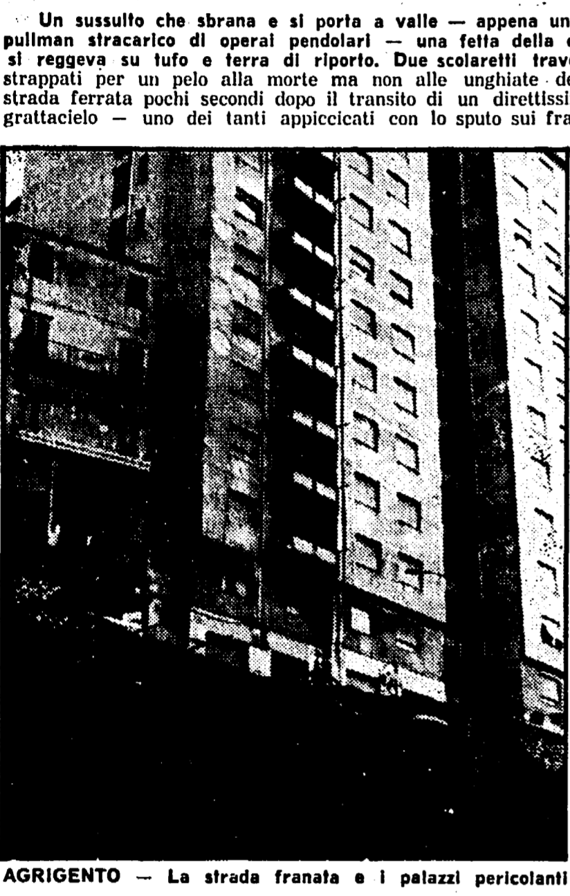
AGRIGENTO - La strada franata e i palazzi pericolanti
