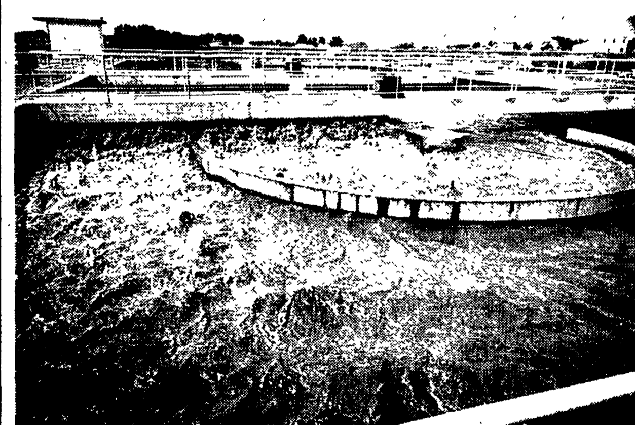
Una delle grandi vasche di un depuratore.
