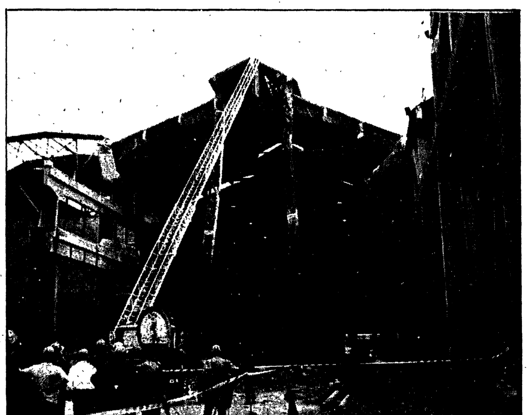
Tre operai sono morti alle Acciaierie di Terni: stavano lavorando sul tetto di un vecchio capannone che doveva essere demolito quando la faliscante costruzione ha ceduto. I tre - Lanfranco Belli, Giovanni Campana e Giuseppe Padavini - sono precipitati nel vuoto da un'altezza di venticinque metri: schiacciati dal cemento armato e dai massi, sono rimasti uccisi praticamente sul colpo. Pronto è stata la reazione di tutti gli operai del complesso siderurgico: è stato sospeso il lavoro; per oggi sono previste interruzioni del lavoro ed assemblee. Il gravissimo triplice omicidio bianco ripropone il problema delle ditte appaltatrici (i tre infatti erano alle dipendenze di una ditta che aveva subappaltato i lavori di demolizione) e le gravissime responsabilità delle aziende dell'IRI in questo campo. Nella foto: il capannone della tragedia A PAGINA 6
