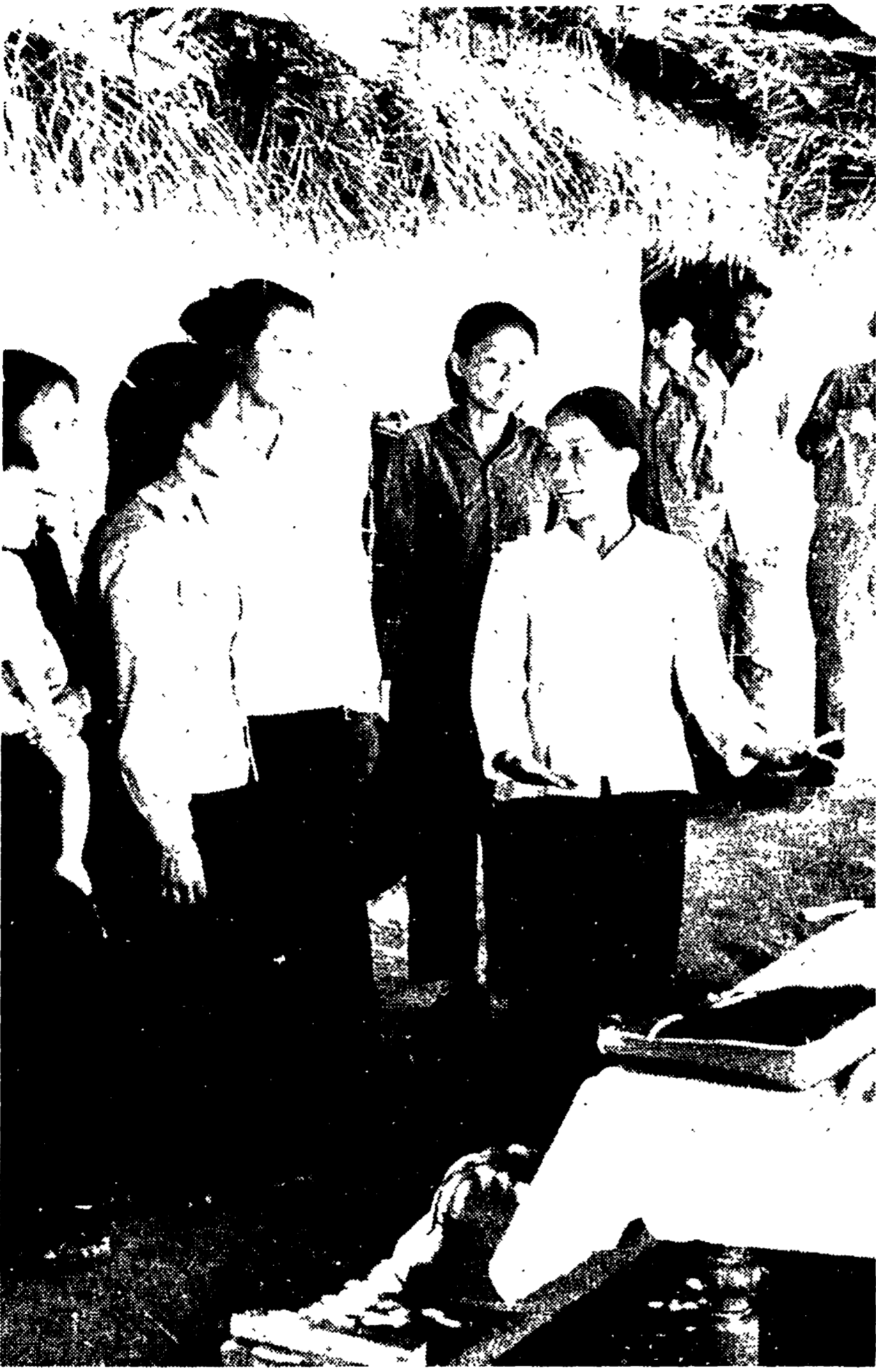
Una squadra di donne che partecipa ai lavori di riparazione del ponte di Cup.
