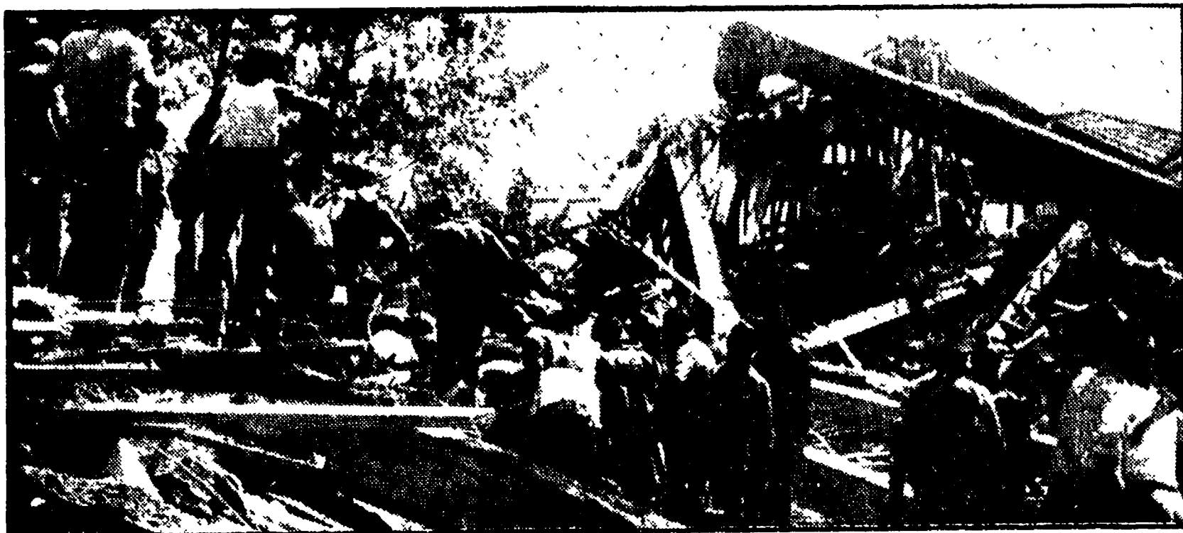
TORINO — Squadre di vigili del fuoco al lavoro tra le macerie del capannone crollato
