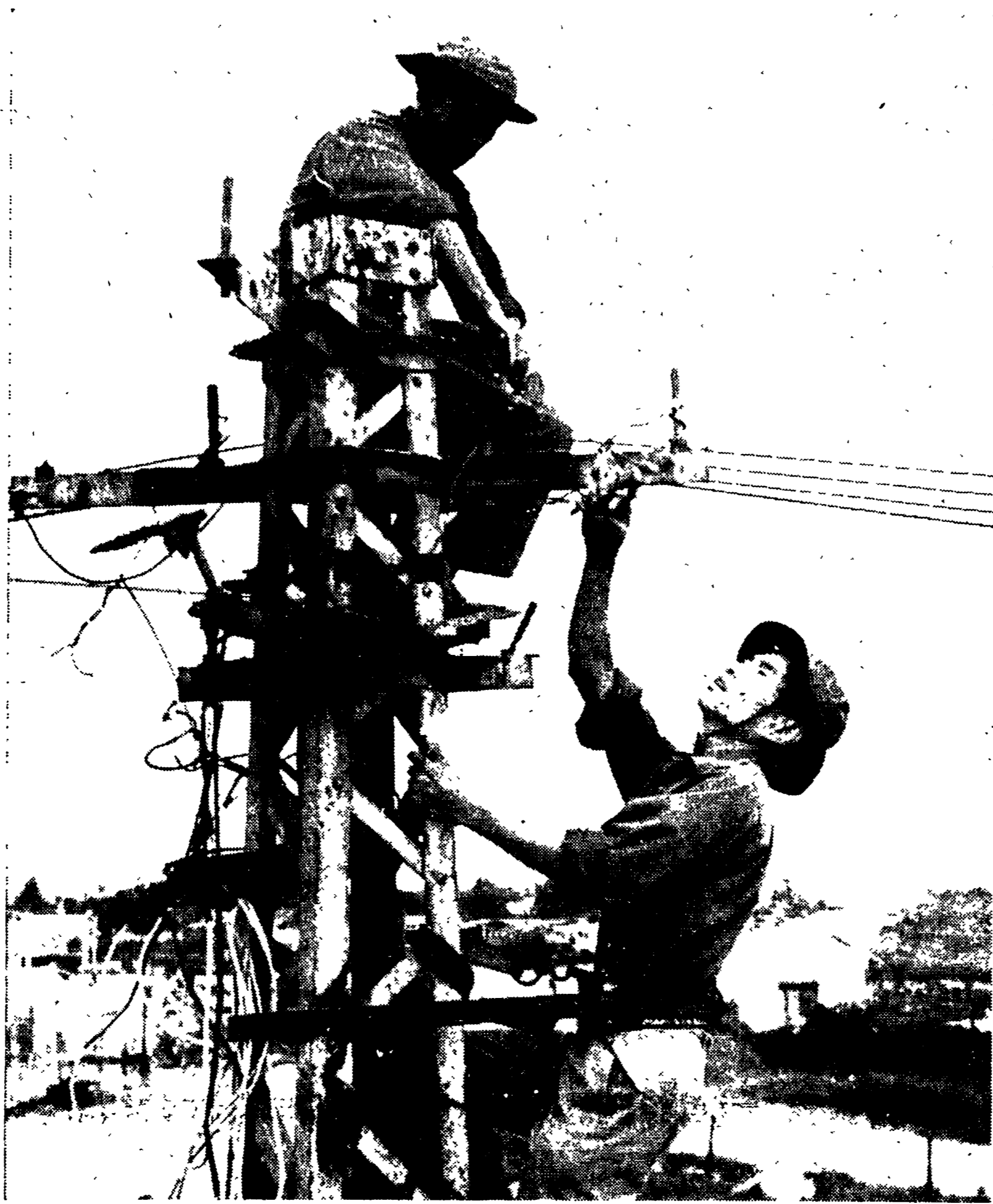
QUANG TRI — Si riparano le linee della corrente elettrica nelle zone liberate attorno a Quang Tri.
