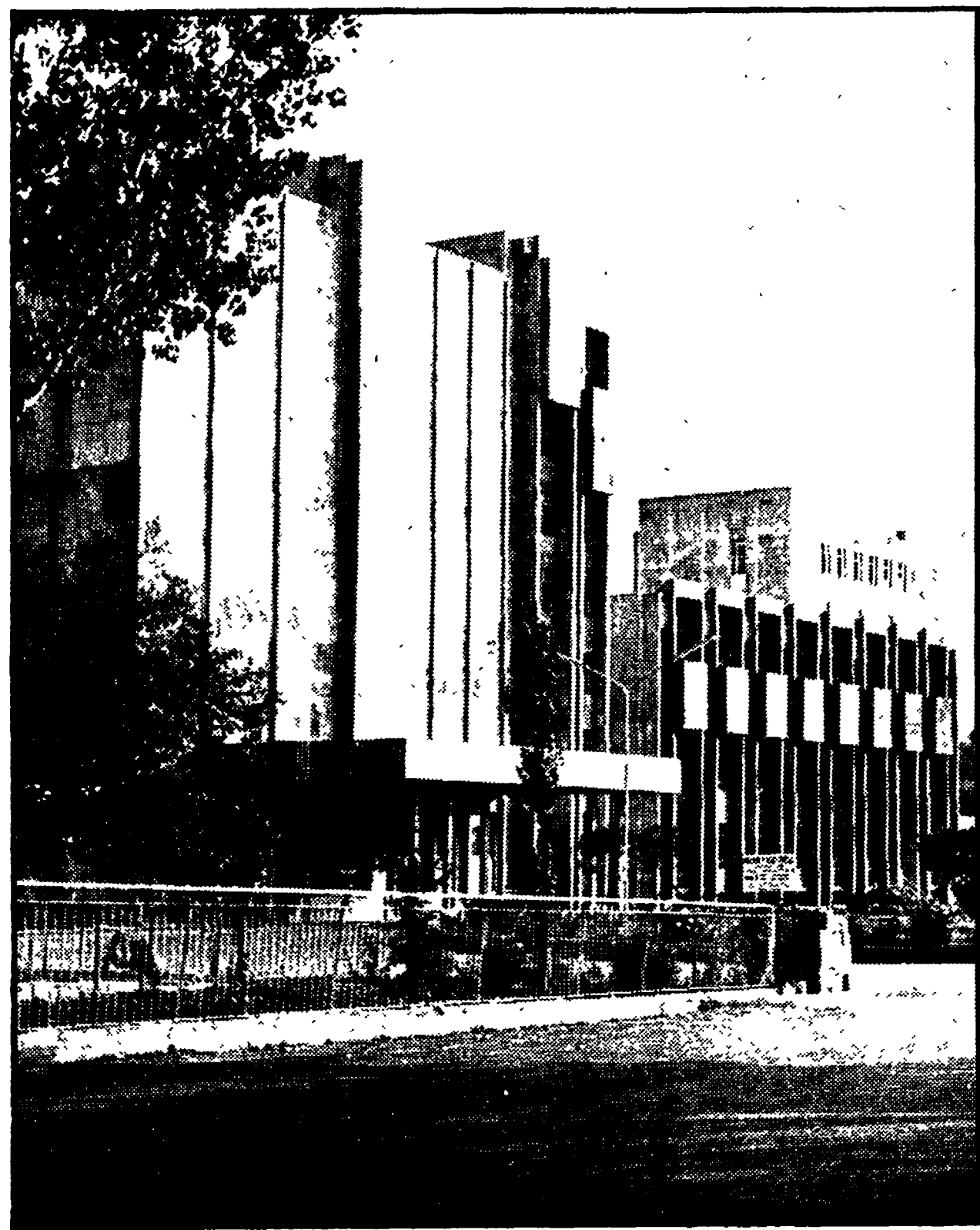
Questi sono i nuovi silos che la società molitoria «Pietro Agostinelli» ha costruito nei pressi di via della Pisana. Altri silos esisterebbero a Civitavecchia e nei pressi di Pomezia. Quanto grano è immagazzinato in questi depositi? Secondo alcune indiscrezioni Agostinelli avrebbe scorte fino alla fine di settembre. Perché questo grano non viene messo in circolazione?
