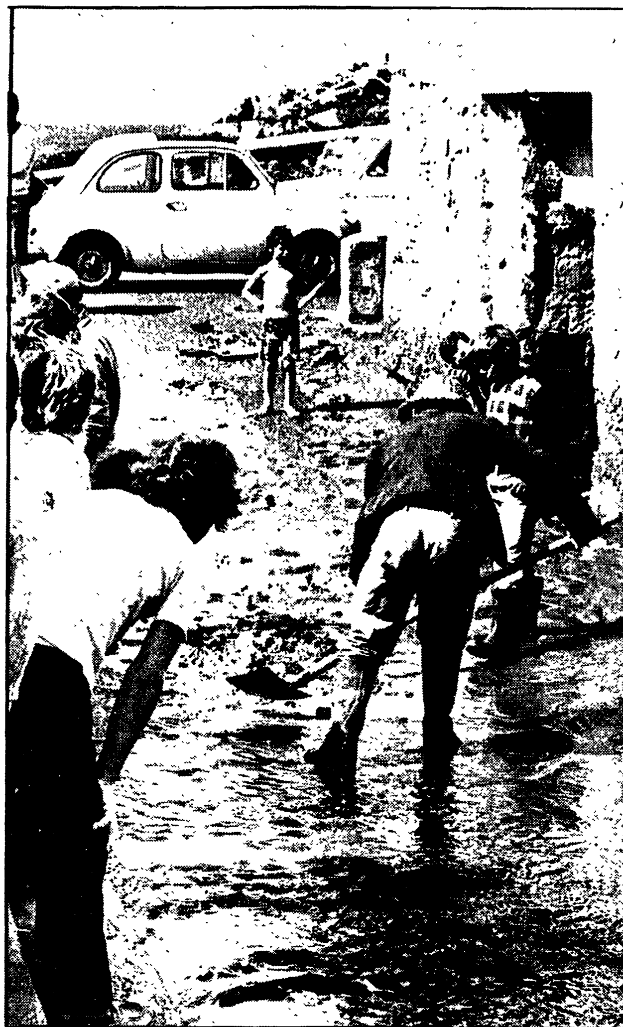
TORRE DEL GRECO — In una strada un uomo è al lavoro per eliminare i liquami di fogna, uno dei più pericolosi focolai di infezione
