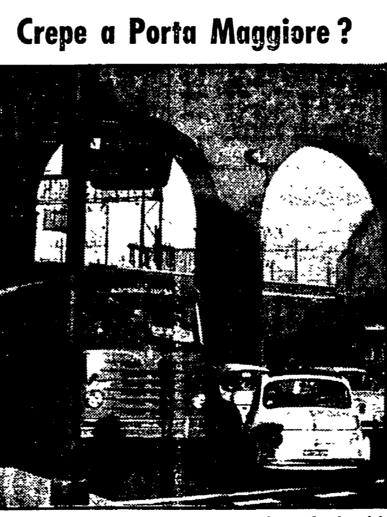
Pezzi di calcinaccio sono caduti ieri sera da un fornace dell'acquedotto a Porta Maggiore lungo via Eleniana. Si è pensato immediatamente al pericolo di crolli, provocati dalle vibrazioni del traffico, anche se l'ingegner Pastorelli, della Commissione stabili pericolanti dei vigili del fuoco non ha ritenuto opportuno transennare la strada. Ha comunque avvertito il genio civile e le belle arti, per effettuare un sopralluogo congiunto. NELLA FOTO: gli archi dell'acquedotto a Porta Maggiore.
