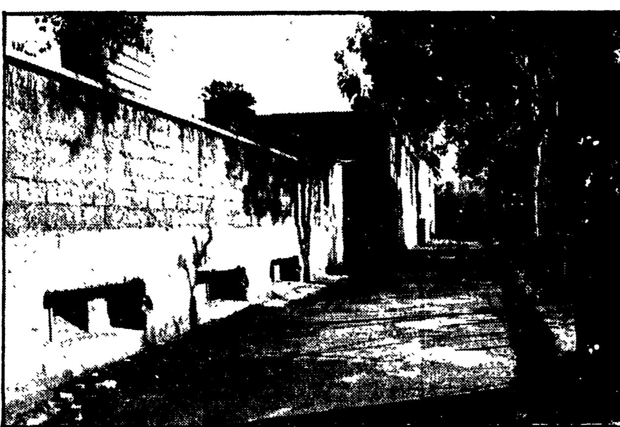
Scuola fatiscente a Torre Angela
