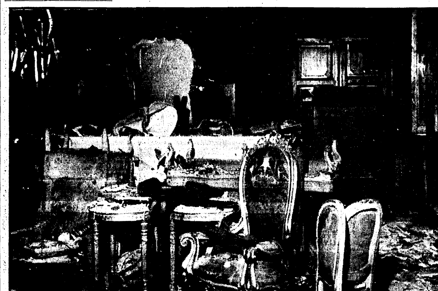
FIRENZE - Un aspetto del salone colpito dall'incendio
