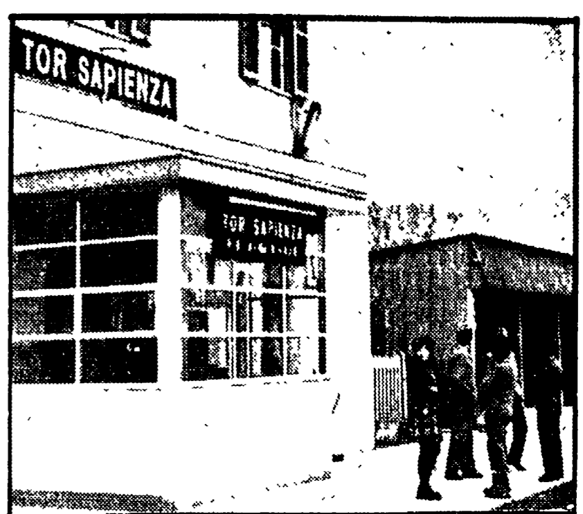
L'impiegato della stazione ferito dai banditi. A destra: l'ingresso della stazione
