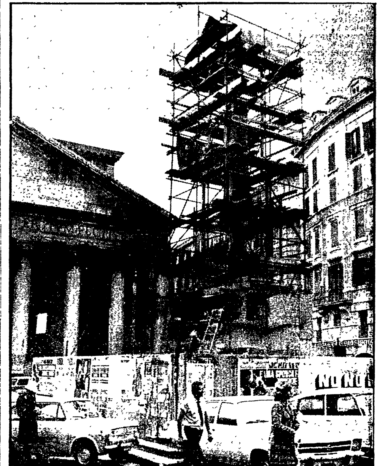
L'obelisco del Pantheon, ormai da molti mesi, è ancora «sospeso» nel vuoto. Con una nuova tecnica — una «fasciatura» di tubi Innocenti — si è riusciti a lasciare al suo posto il troncone finale del monumento, asportandone solo la parte inferiore. Il provvedimento si è reso necessario per evitare il crollo dell'obelisco. Infatti, in seguito alle vibrazioni causate dal traffico e all'erosione del tempo e dello smog la struttura interna e le iscrizioni egiziane al base sono definitivamente rovinate. Dopo questo intervento, che consisterebbe in un'iniezione di cemento e in una delicata opera di restauro l'obelisco potrà tornare a essere visto «intero» dai romani. Nella foto: l'obelisco sospeso a mezz'aria
