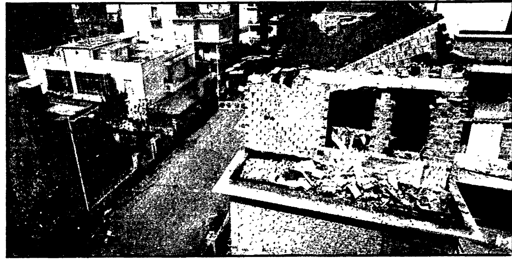
La sopraelevazione abusiva sul tetto dell'asilo in via Poggio Bracciolini, parzialmente crollata
