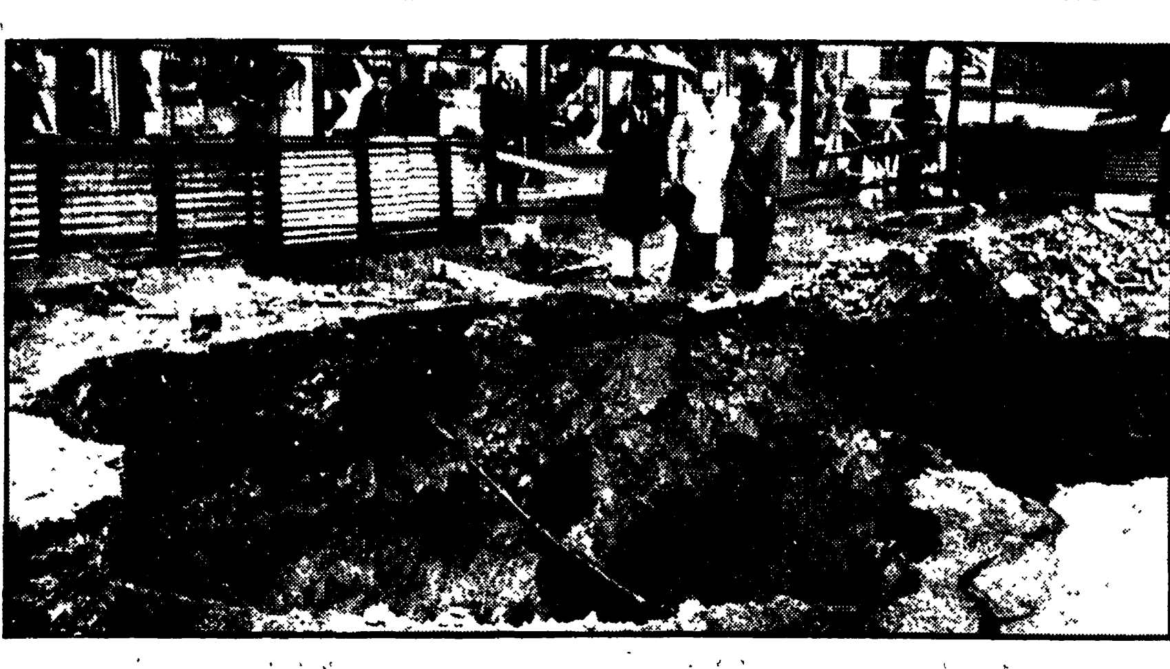
CROLLI E VORAGINI PER IL MALTEMPO Una voragine di 60 metri quadrati e profonda oltre un metro, in via di Valle Aurelia, un'altra di 120 metri quadrati e profonda oltre un metro, in via di Valle Aurelia, un'altra di 120 metri quadrati e profonda oltre un metro, in via di Valle Aurelia...
