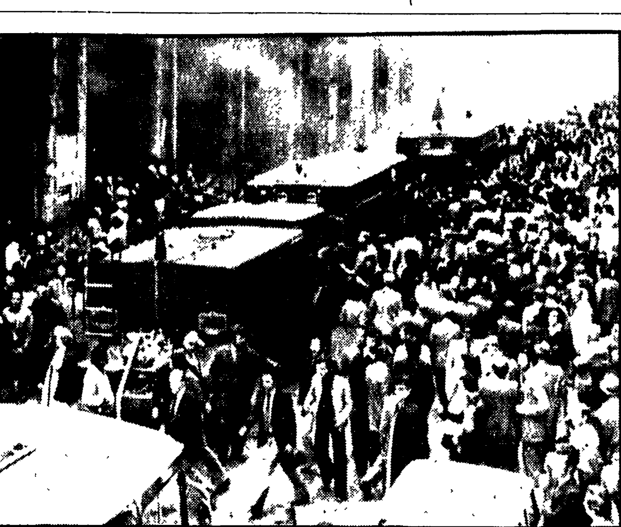
INCENDIO IN BANCA A NAPOLI NAPOLI, 9. — Un incendio di vaste proporzioni scoppiato ieri mattina — probabilmente per un corto circuito — nella sede centrale del Banco di Napoli, nel cuore della città, in via Roma. I danni non sarebbero di grande entità; ma l'opera di spegnimento non è stata priva di momenti di notevole drammaticità. Per far fronte in salvo alcuni doppiopiani (due all'ospedale) è stato necessario l'uso delle scale. Due vigili del fuoco hanno riportato confusioni e ustioni.
