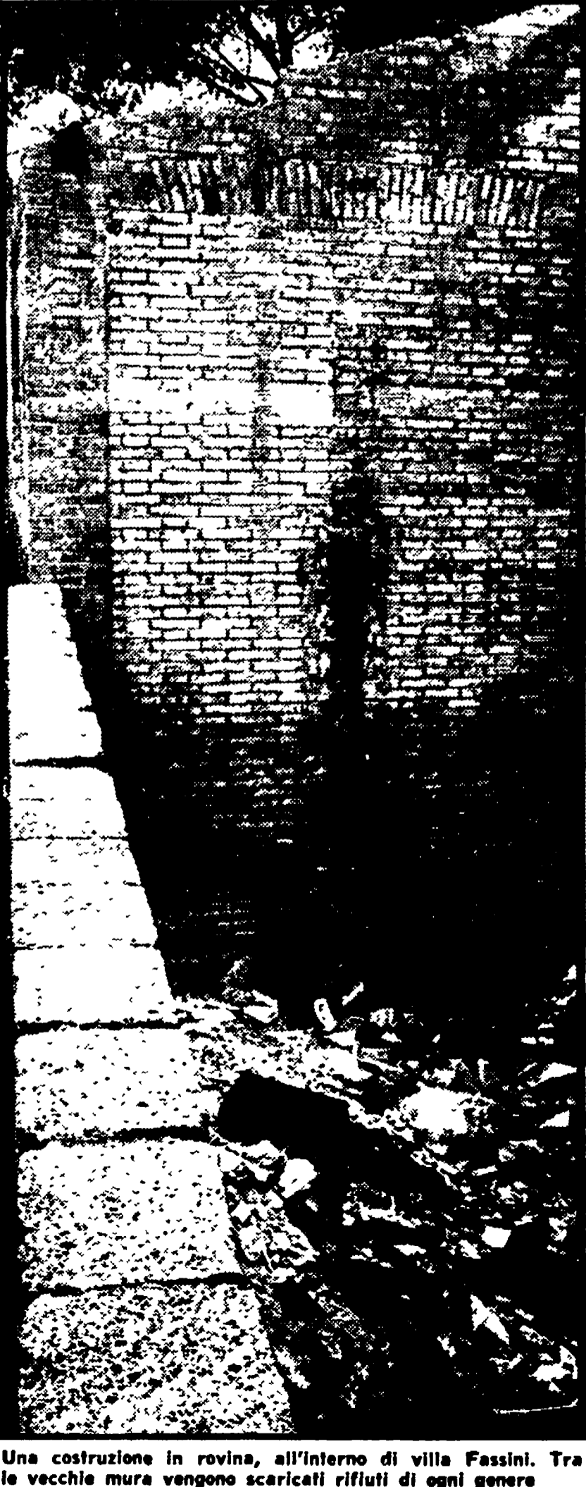
Una costruzione in rovina, all'interno di villa Fassini. Tra le vecchie mura vengono scaricati rifiuti di ogni genere
