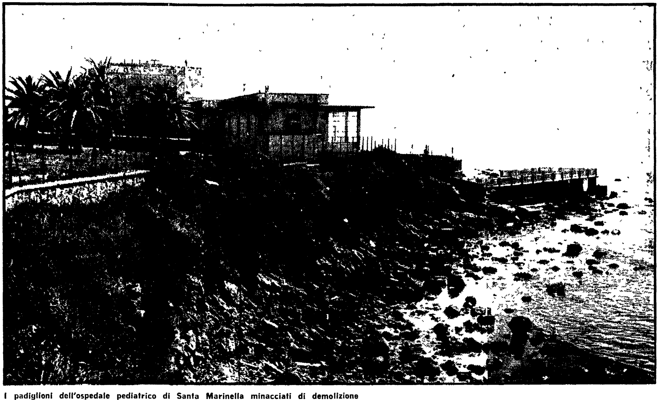
I padiglioni dell'ospedale pediatrico di Santa Marinella minacciati di demolizione
