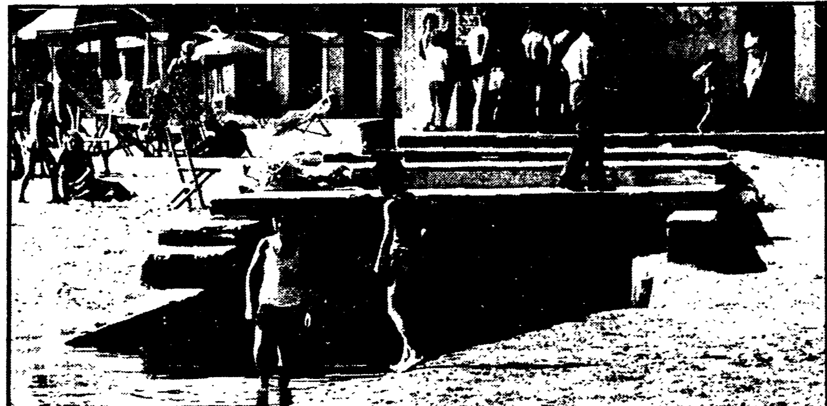
Lo sbocco a mare del fosso della Loricina, a Nettuno, che trasporta gli scarichi del mattatoio
