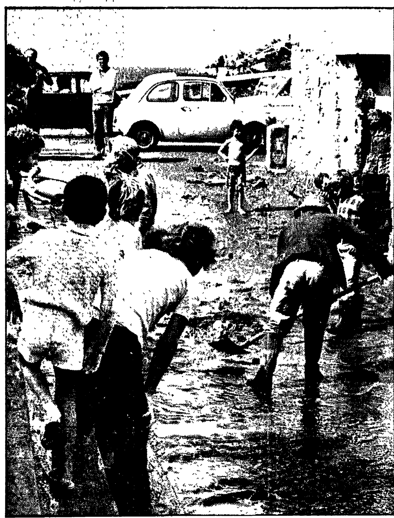
NAPOLI - I lavori nelle fognature, disposti dopo il colera, sono stati sospesi per mancanza di fondi
