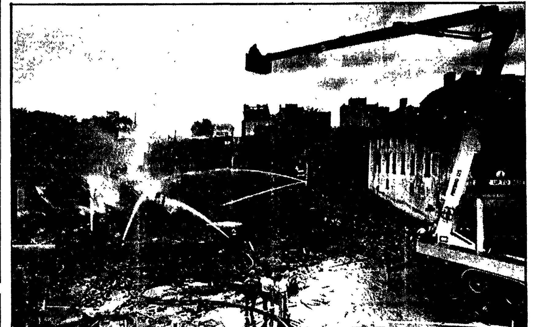
CHATTANOOGA (Tennessee), 29. Una violenta esplosione nel centro di Chattanooga ha raso al suolo quattro edifici, fra cui anche una chiesa, distruggendo un intero quartiere, 13 finora i feriti accertati; ma si cercano i dispersi. L'esplosione ha sconvolto una zona popolata da gente di colore, ha provocato
