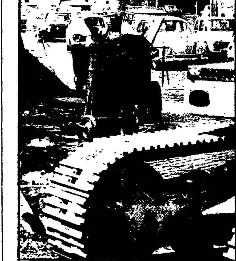
I lavori in corso a Portonaccio
