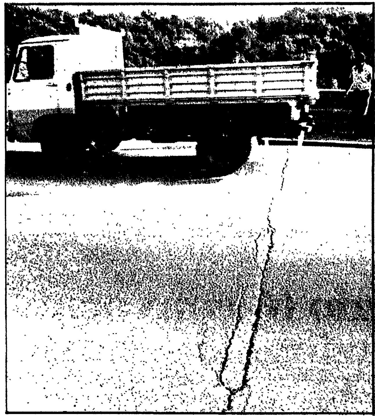
Una crepa - che i tecnici non giudicano preoccupante - del ponte di Ariccia
