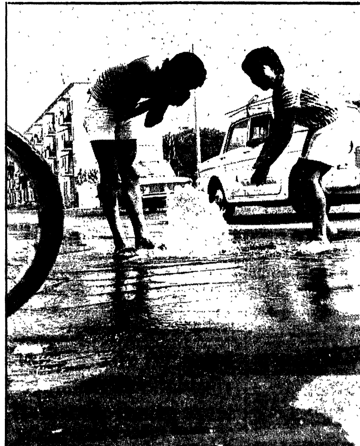
Alcuni ragazzi del quartiere dinanzi a una condotta d'acqua rotta
