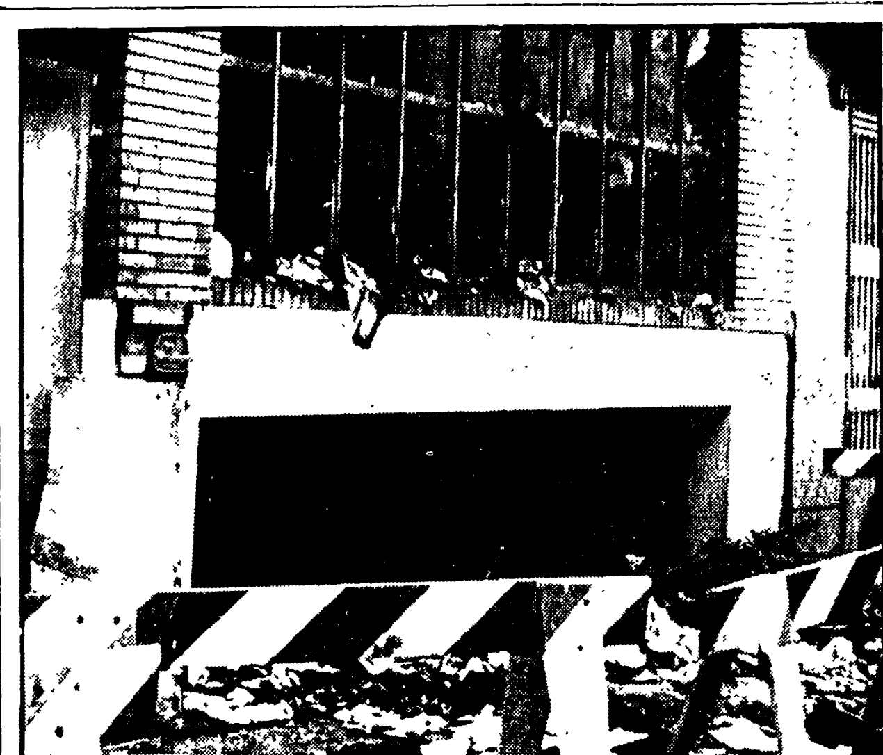
MILANO - I danni provocati dall'incendio di ieri notte agli uffici dell'autonegozio AVIS
