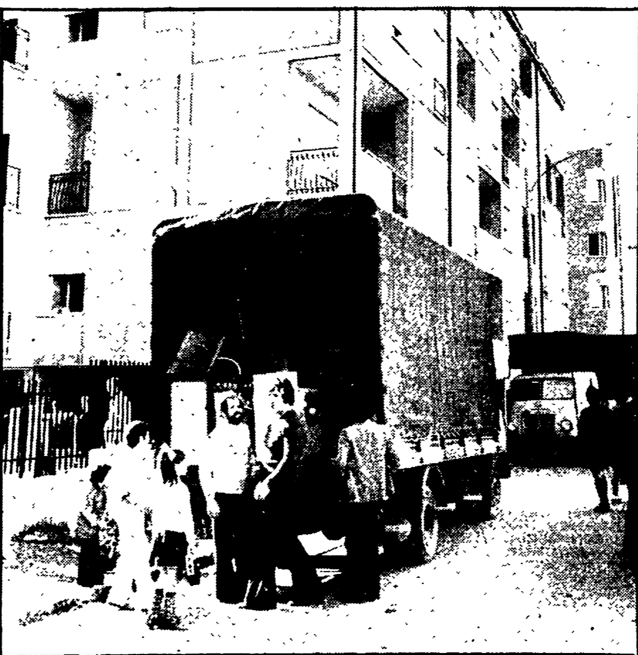
Le operazioni di trasloco nelle palazzine dell'IACP a S. Basilio
