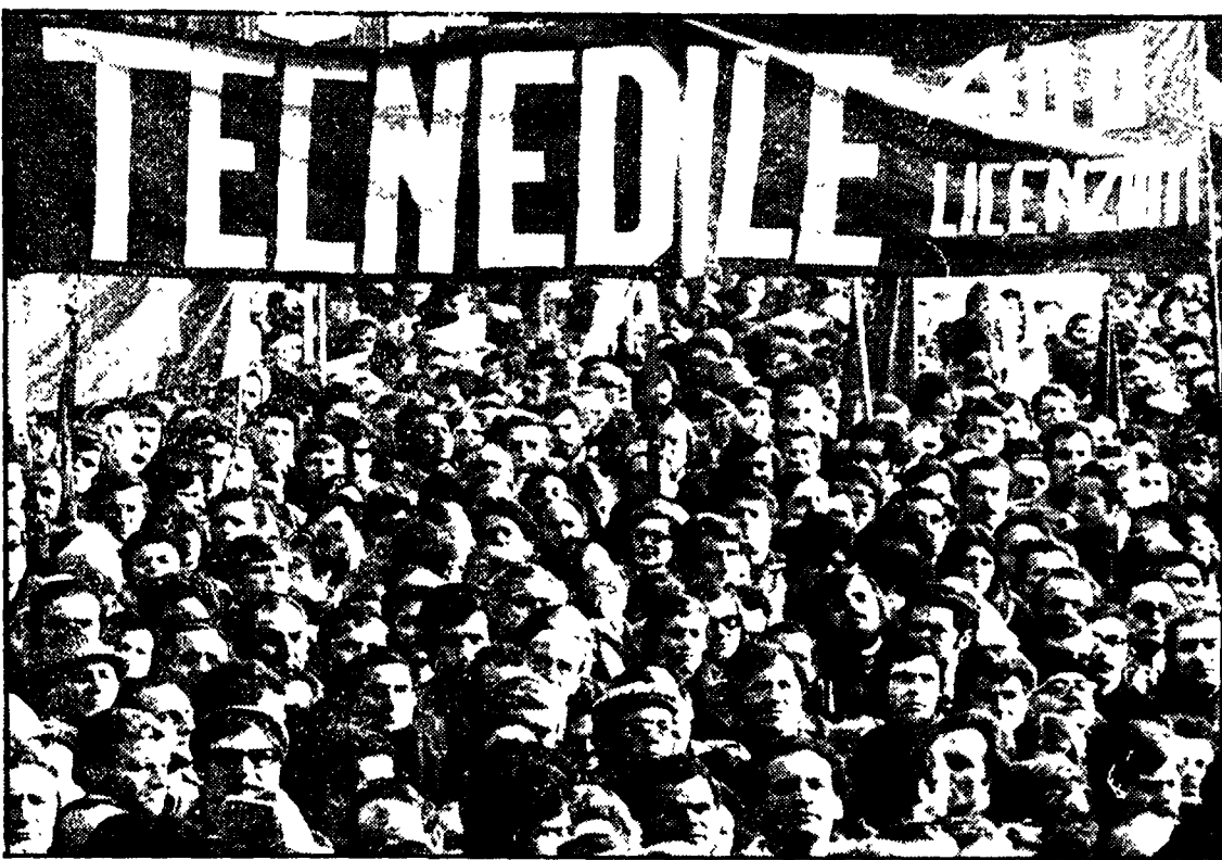
Completamente deserti ieri i cantieri edili della zona Appia-Tuscolana ed EUR, dalle 9 alle 12, ora in cui era stato indetto lo sciopero in difesa dell'occupazione. I lavoratori si sono recati in corteo (come si vede nella foto) davanti ai cantieri della Tecnedit, che costruisce per conto dell'immobiliare Beni e ha licenziato oltre 400 persone. Nel corso della manifestazione hanno preso la parola Porcheddu, della FLC e Belli della FILLEA. Nei prossimi giorni ci sarà un incontro all'ufficio del lavoro con l'ACER, sul problema della Tecnedit
