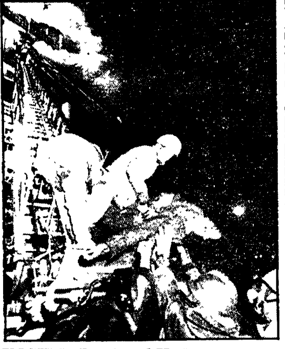
INCENDIO A TOKIO Nelle prime ore del mattino di venerdì è scoppiato a Tokio un violento incendio in un edificio...
