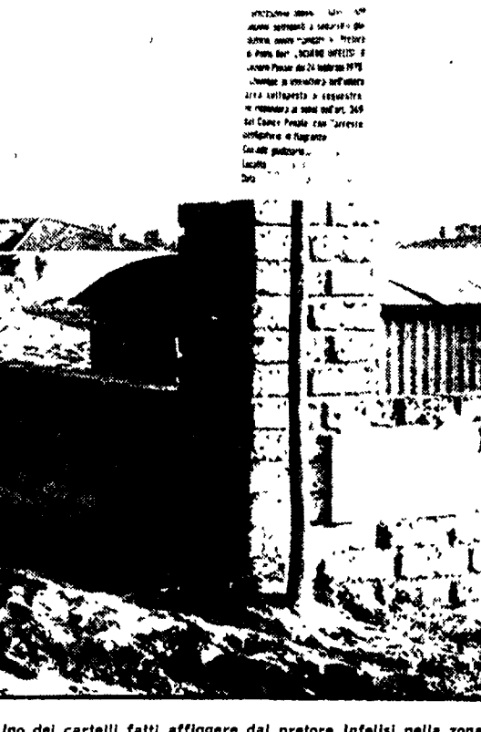
Uno dei cartelli fatti affiggere dal pretore Infelisi nella zona «la Lingua» tra Casalpalocco e il mare
