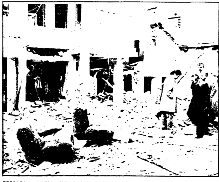
FERRARA — L'edificio distrutto dalla violenta esplosione
