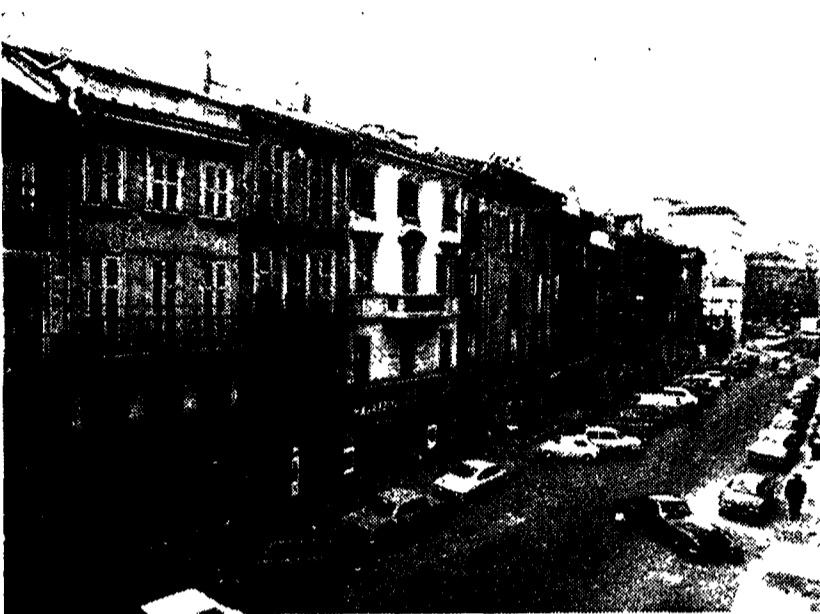
MILANO - Nel 1972, con una lotta unitaria, il centrale quartiere Garibaldi ha conquistato il vincolo a edilizia popolare di tutti gli edifici e le aree del corso, aprendo la strada all'applicazione della 167 sull'edilizia degradata per una ristrutturazione sottratta alla speculazione immobiliare.
