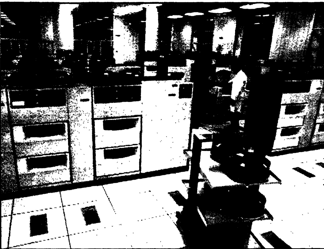
La sala delle memorie del Centro elettronico dell'anagrafe tributaria del ministero delle Finanze. Si è scoperto solo a cose fatte che questo « cervello » centrale non funziona poiché non è in grado di reggere il carico di informazioni che dovrebbe ricevere dalle varie regioni del paese
