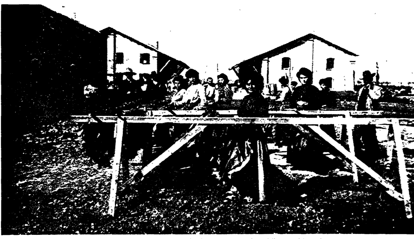
La lavorazione del tabacco nelle grandi aziende delle bonifiche ferraresi in una foto dell'inizio del secolo.
