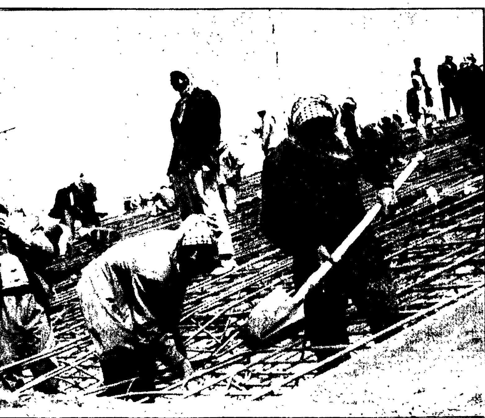
Lavori alle attrezzature idroelettriche della diga sull'Eufrate
