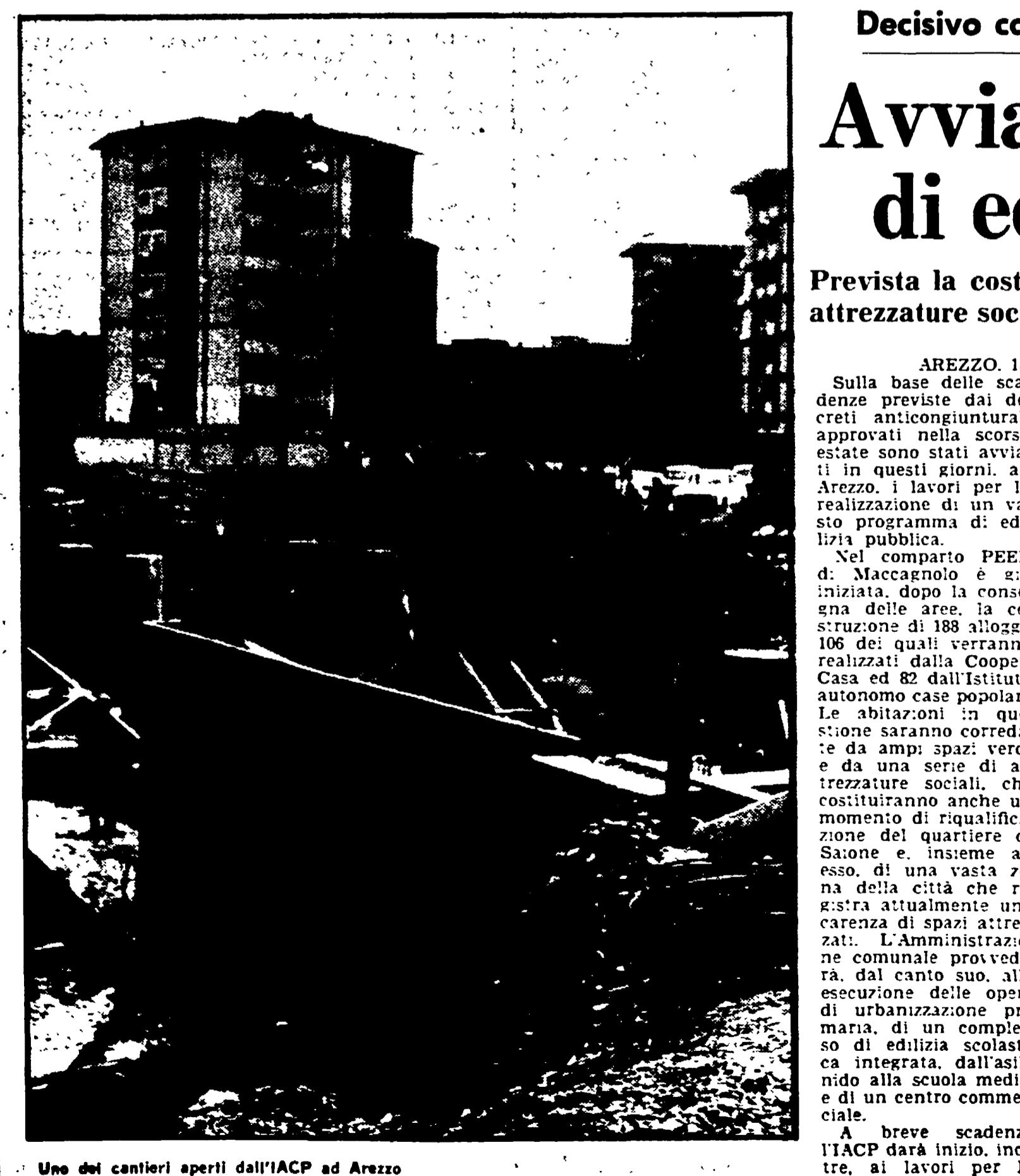
Uno dei cantieri aperti dall'IACP ad Arezzo
