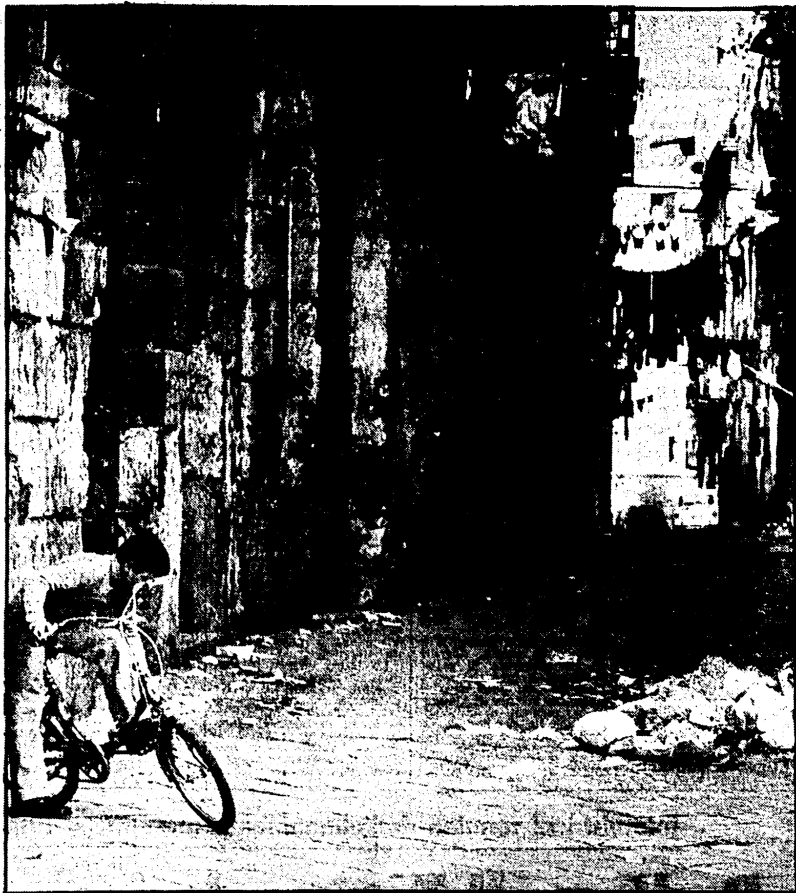
Un particolare dello stato di abbandono e disgregazione del centro storico di Palermo. In questi giorni si sviluppa un forte movimento unitario per il risanamento
