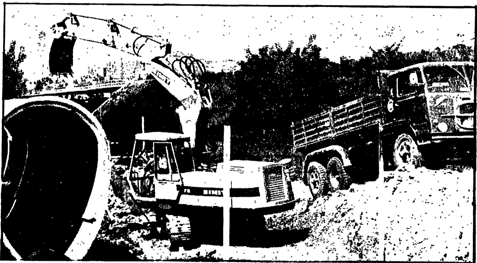
I lavori per la costruzione di un tratto di fognatura
