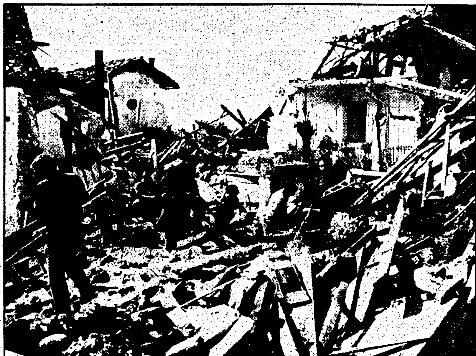
UDINE — Maiano è uno dei centri maggiormente colpiti dal tremendo terremoto di giovedì sera. Interi quartieri distrutti, case vecchie e anche di recente costruzione sono state rase al suolo dalla violenza del sisma. NELLA FOTO: alcuni superstiti cercano tra le macerie
