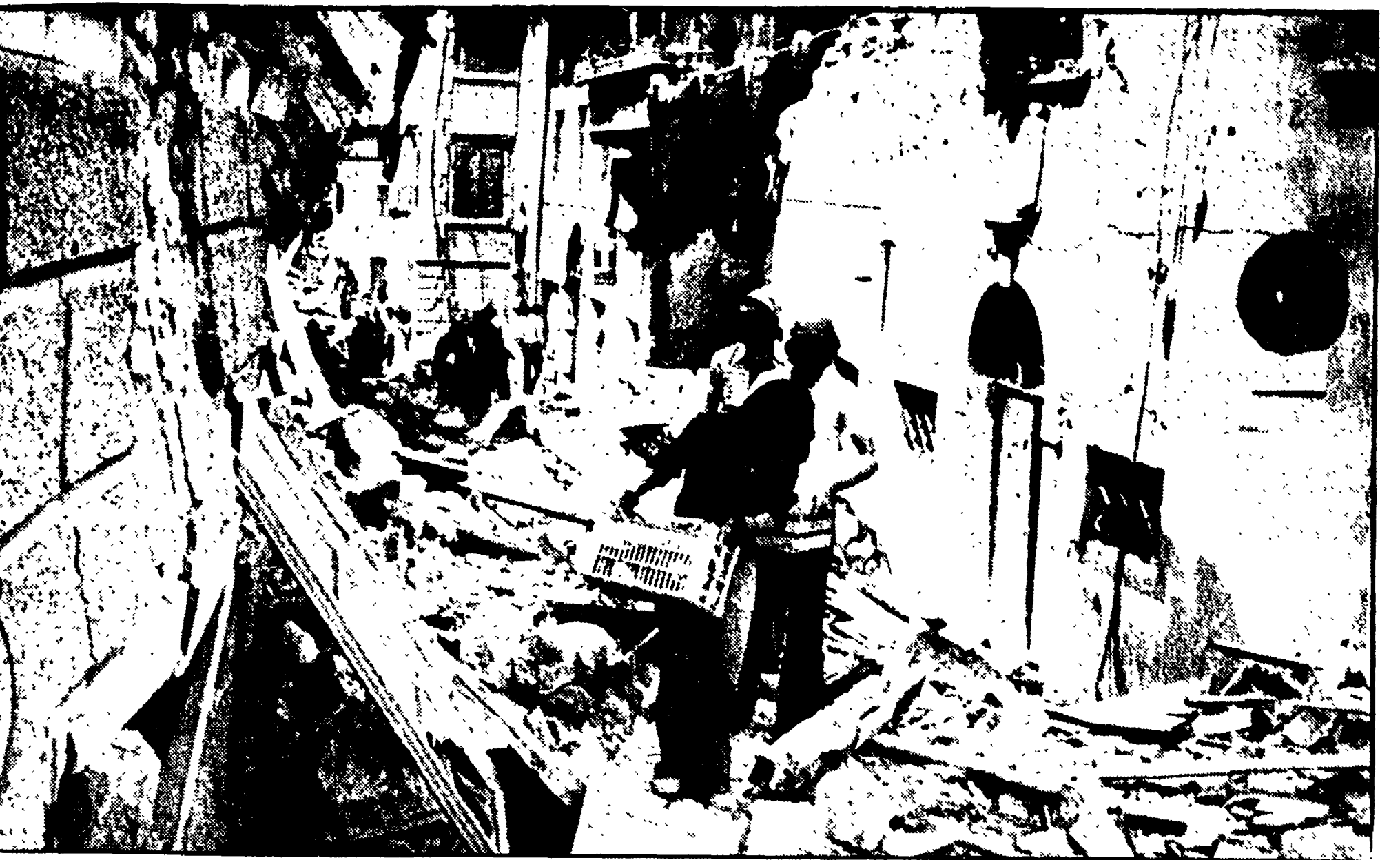
Una via di Maiano devastata dal terremoto
