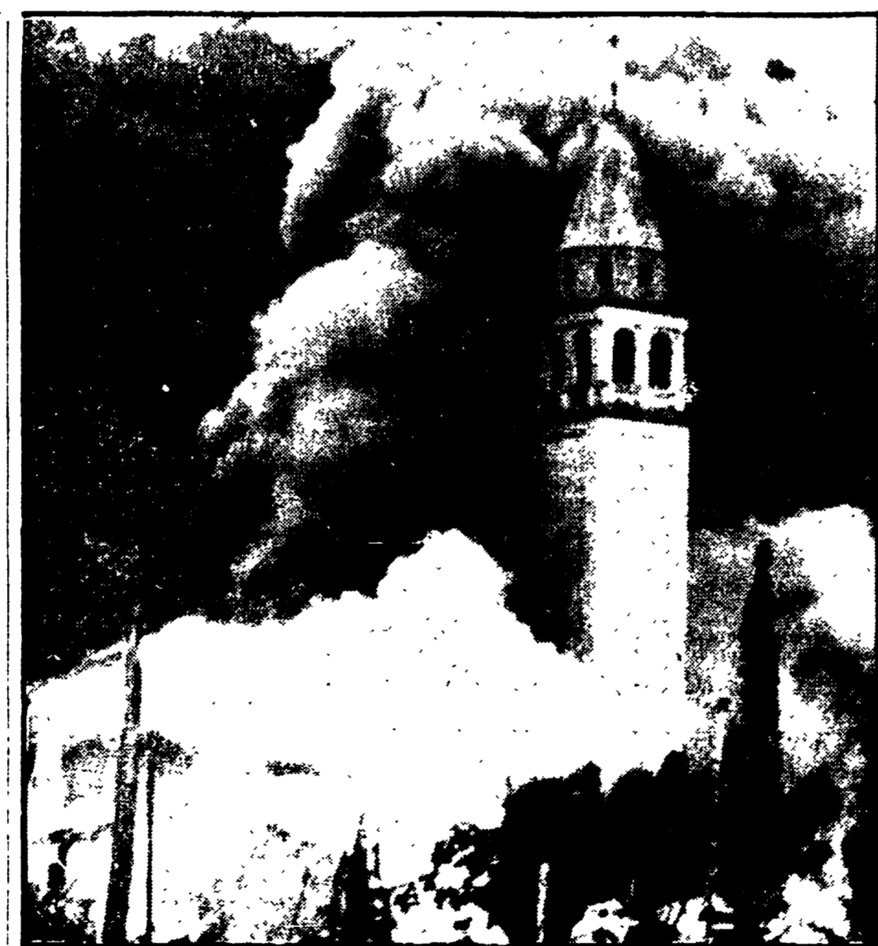
RESISTE ALLE SCOSSE E AL TRITOLO. Ha resistito a terremoto e a tritolo il campanile della chiesa di Santa Maria ad Nives a Osoppo. Ritenuto pericolante (e quindi una potenziale minaccia per le abitazioni circostanti) è stato minato con cinquanta chili di tritolo.
