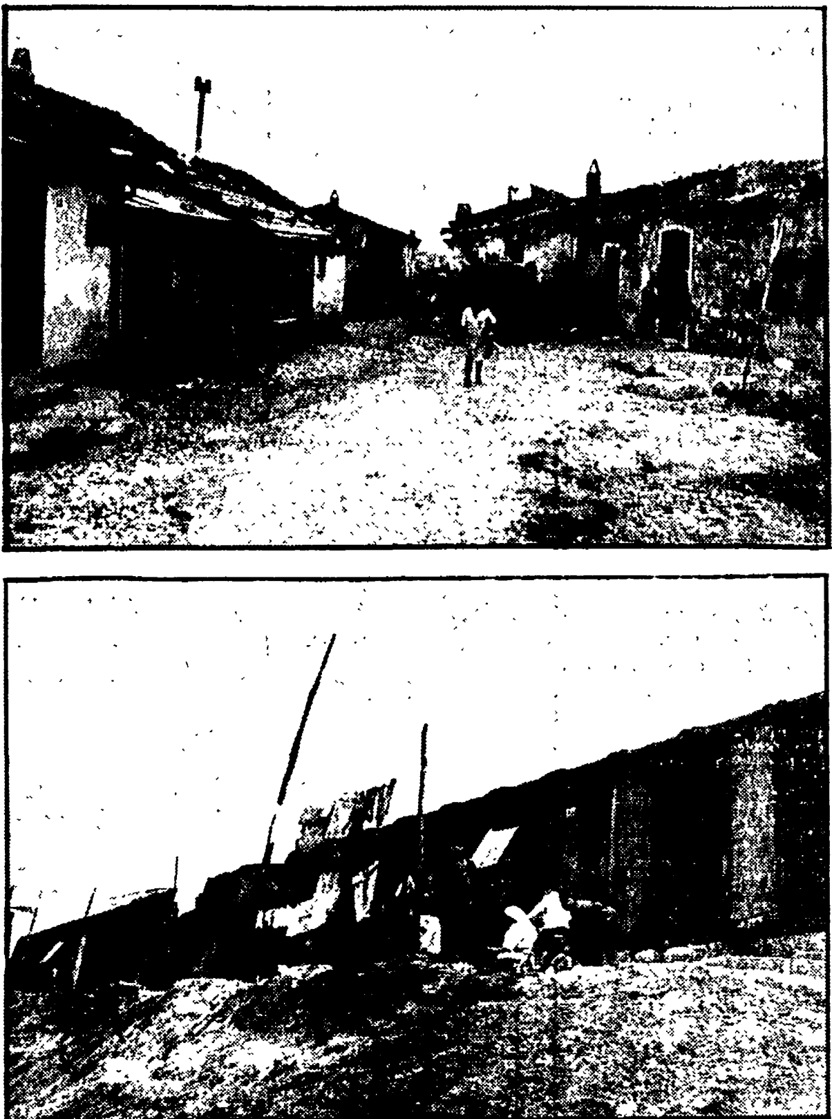
NELLE FOTO: in alto, le casette antisismiche costruite dopo il terremoto del 1930 sono ancora abitate, nonostante le carenze igieniche e di manutenzione. Qui vediamo quelle di Montecalvo Irpino; foto in basso, sempre a Montecalvo sono ancora utilizzate — ospitano una decina di famiglie — delle baracche in ferro più simili a vagoni ferroviari che ad abitazioni vere e proprie (Le foto sono di M. Riccio)
