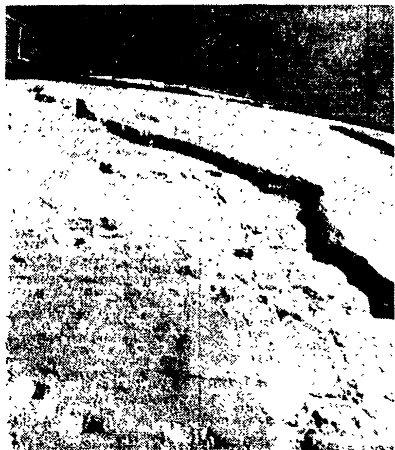
Due eccezionali documenti fotografici che pubblichiamo fanno vedere una parte della lesione che solca la cupola del Pantheon smantellata delle lastre di piombo per restauri.
